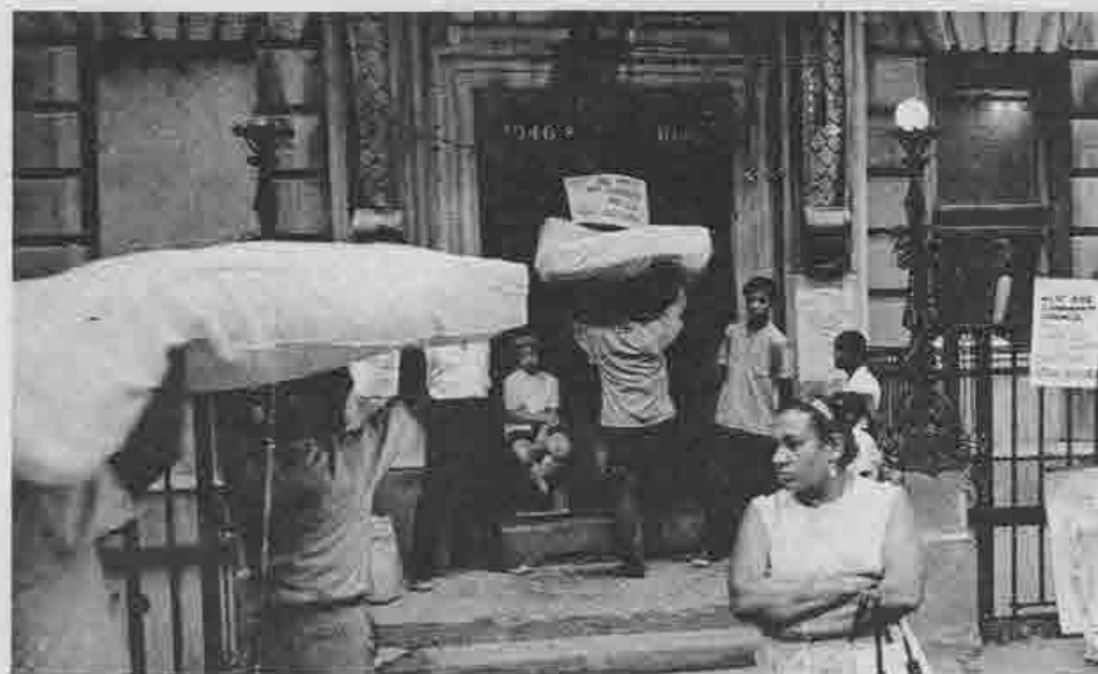
Occupazione di case che dovrebbero essere demolite.
